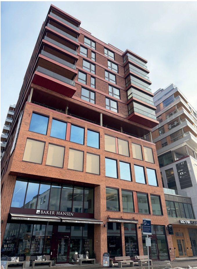
Helgerudkvarteret er et stort byutviklingsprosjekt i Sandvika sentrum.
